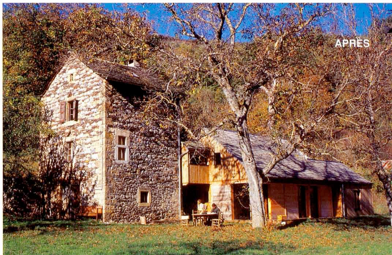
Un passage couvert relie le nouveau bâtiment à l'ancien.
